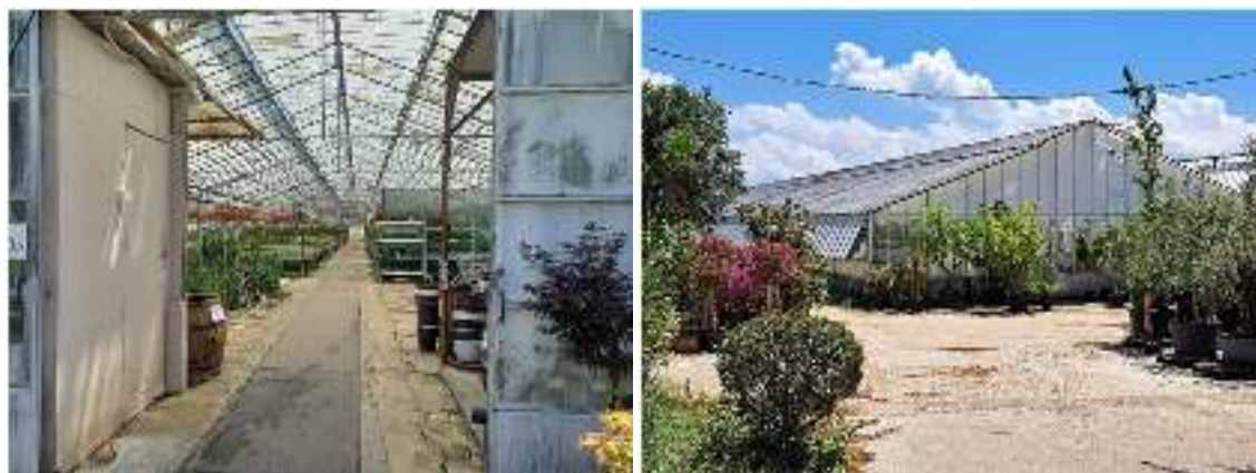
Slika 9. Postojeća zgrada B (staklenik) predviđena za rekonstrukciju
