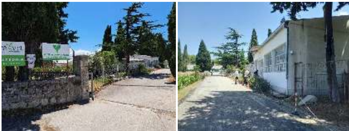
Slika 8. Postojeća zgrada A predviđena za rekonstrukciju
