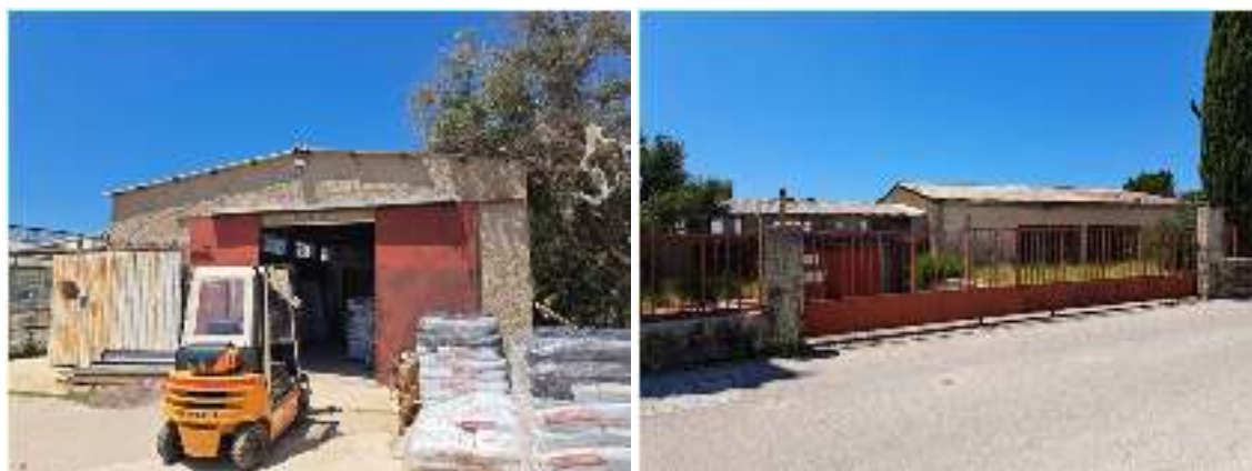
Slika 10. Postojeće zgrade C i E planirane za rekonstrukciju (buduća zgrada C)
